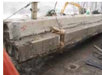
板ジャッキを使用したPC橋解体
