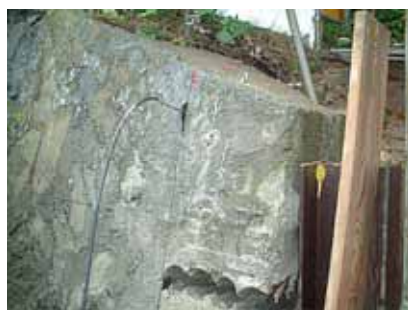
板ジャッキ挿入状態
