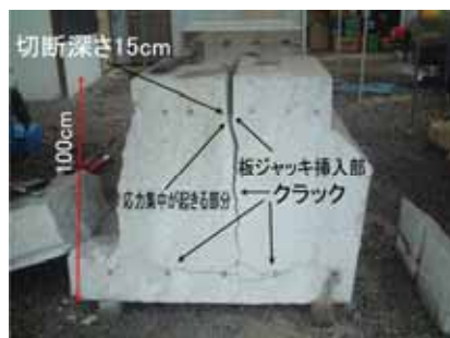
コンクリート破壊状態
